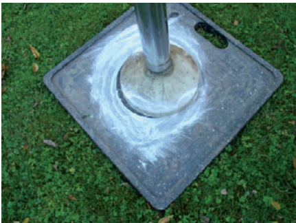
Bild 4-6: ausreichende Lastverteilung
