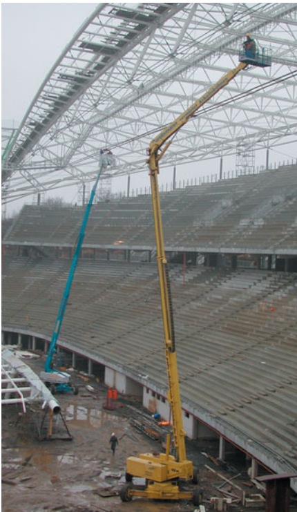
Bild 6-2: Hubarbeitsbühne im Baustelleneinsatz
